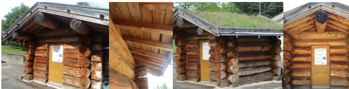
Figure C-1 : Vues de face de la cellule-test en rondin
