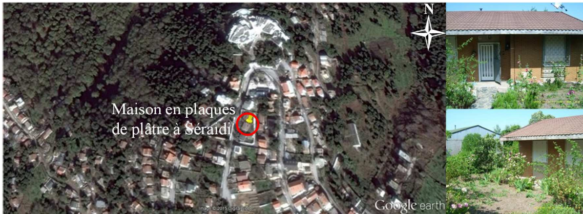
Figure II-48 : Situation de la maison en plaques de plâtre
