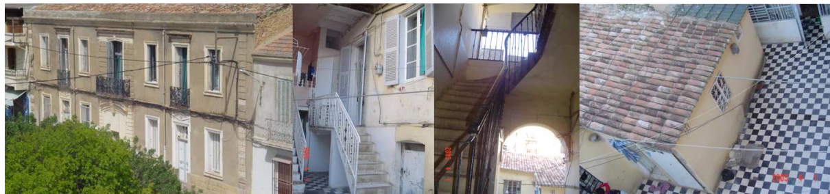
Figure II-36 : Vues sur la maison (côtés rue et cour)
