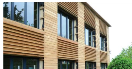
Rénovation groupe scolaire - Dardilly – Source : Observatoire BBC – Tekhnè Architecte
