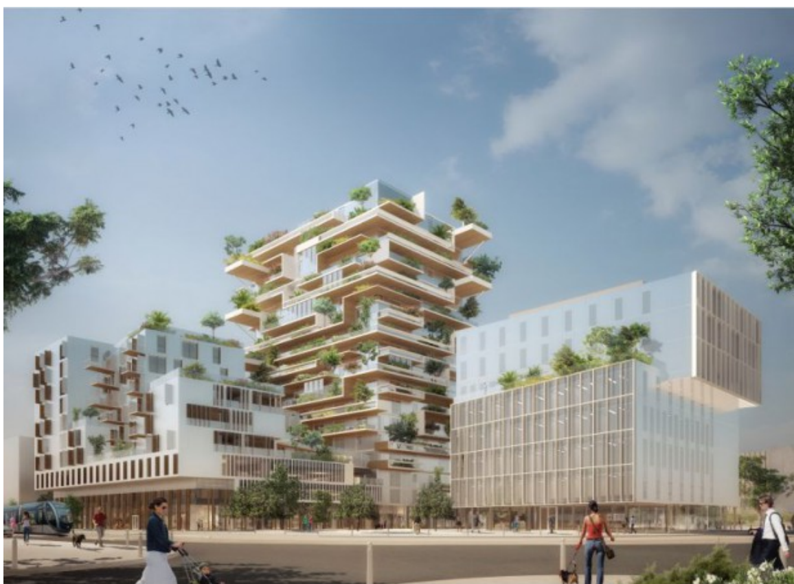
Construction bois bas carbone sur 57 mètres de haut de 82 logements Projet de l'architecte Jean-Paul Viguier à Bordeaux. © Jean-Paul Viguier & Associés
