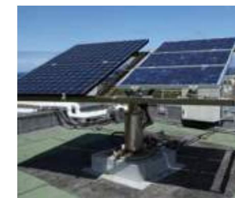
Figure 21 – Banc d'essais de différents panneaux PV
