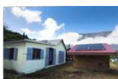
Figure 11 – Projet EDF de micro-grids 100% solaires à Mafate basé sur le stockage par batteries à hydrogène 13
