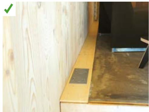
Désolidarisation du plancher dans une construction en bois. ©AQC-2015
