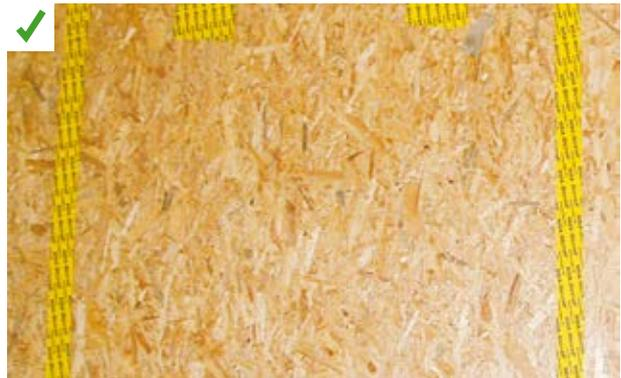
Étanchéité à l'air du bâtiment réalisée par les contreventements.
