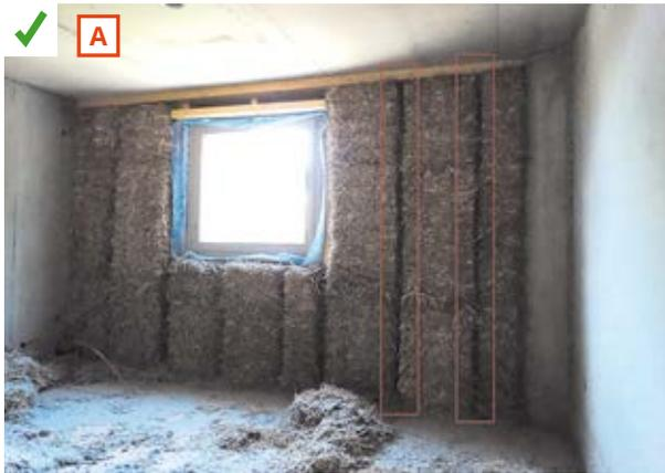
Diminution de la profondeur des montants. ©AQC-2015
