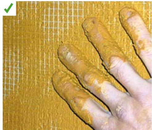
Mise en œuvre du support d'enduit terre avec toile de jute.
